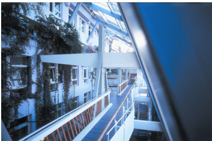
Die Öko-Arche in Frankfurt des Architekten Joachim Eble ist eines der ersten nachhaltig geplanten Bürogebäude. Foto: natureplus
